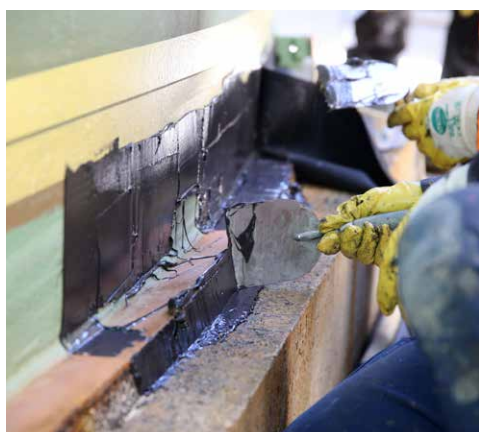
Schritt 4: Abkleben der nicht zu beschichtenden Flächen und Aufbringen von AGRO FIX-O-FLEX KLEBE- & DICHTMASSE
