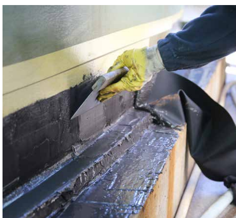
Schritt 5: Gleichmäßiges Verteilen der aufgetragenen Klebe- & Dichtmasse mittels 3mm Rakel.
