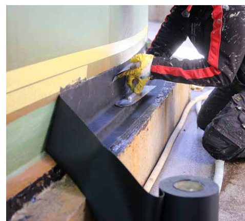
Schritt 6: Einlegen der Proofmate FD-Folie; Entlüften und Anpressen des Klebers mittels Walze und Spachtel.
